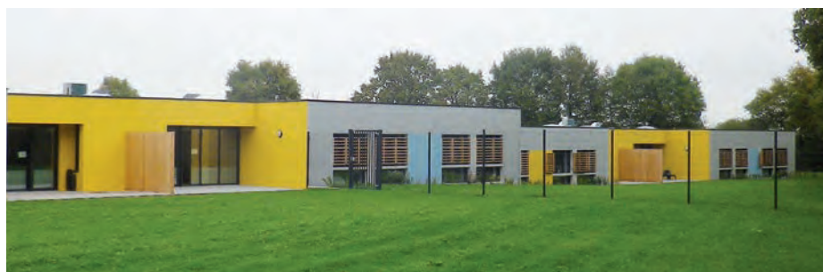
> Le FAM est composé de 4 maisons accueillant chacune 5 personnes et réunissant une unité de vie à part entière : une salle à manger, une kitchenette, un salon, des chambres individuelles avec leur salle de bains et une terrasse.
